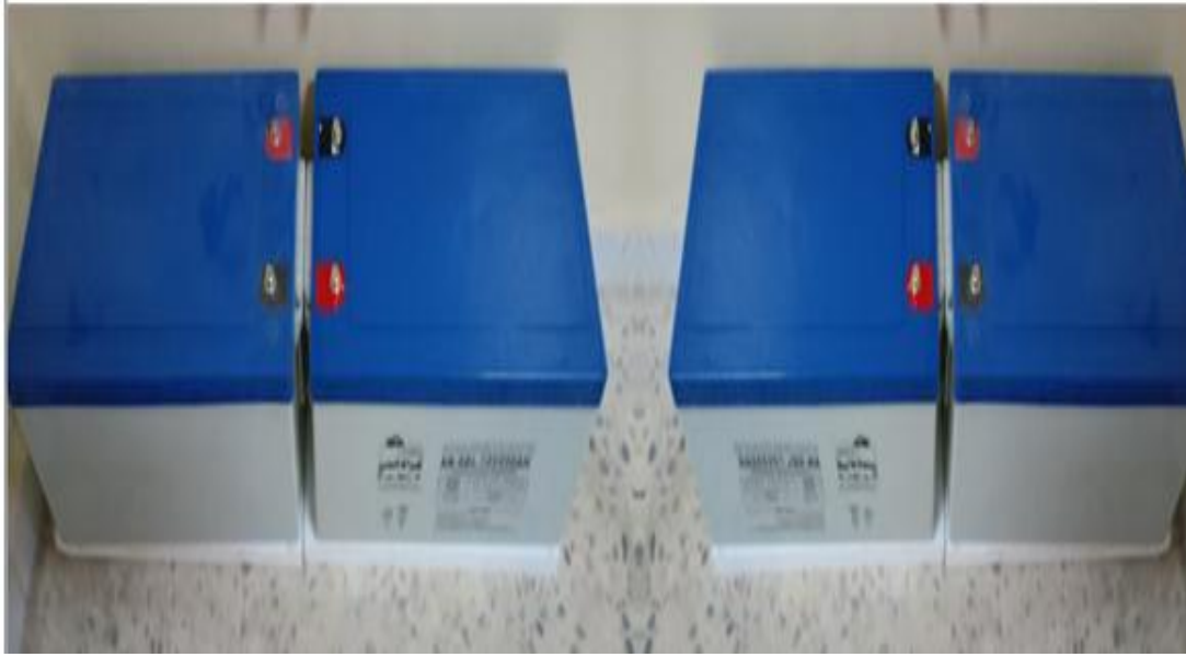
الشكل (8): يبين منظومة بطاريات التخزين الخاصة بالنظام الشمسي.
