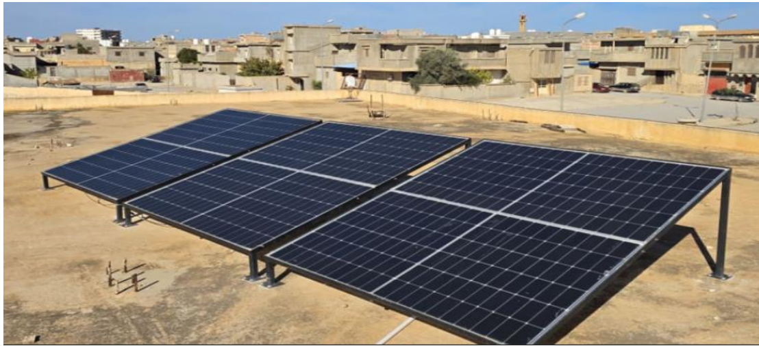
الشكل (5): يبين التركيب الفعلي لمنظومة الألواح الشمسية الكهروضوئية على سطح المبنى
