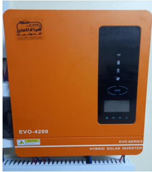
شكل رقم (7): يوضح (EVO-4200-24V Hybrid Solar Inverter)
