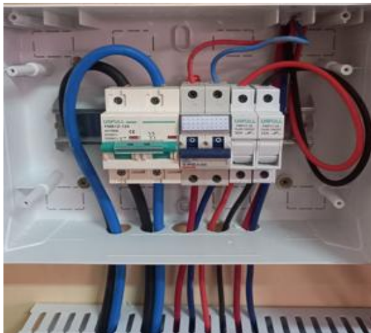
شكل رقم (11): يبين لوحة الحماية الكهربائية لمنظومة الطاقة الشمسية.
