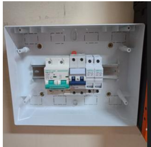
شكل رقم (11): يبين لوحة الحماية الكهربائية لمنظومة الطاقة الشمسية.
