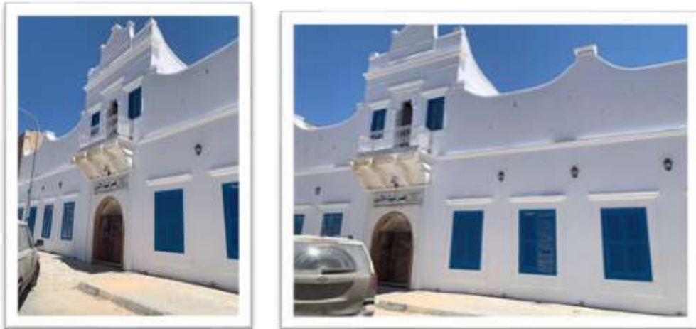
شكل (8): واجهات المبنى بعد عملية الحفاظ المعماري. المصدر : تصوير الباحث
