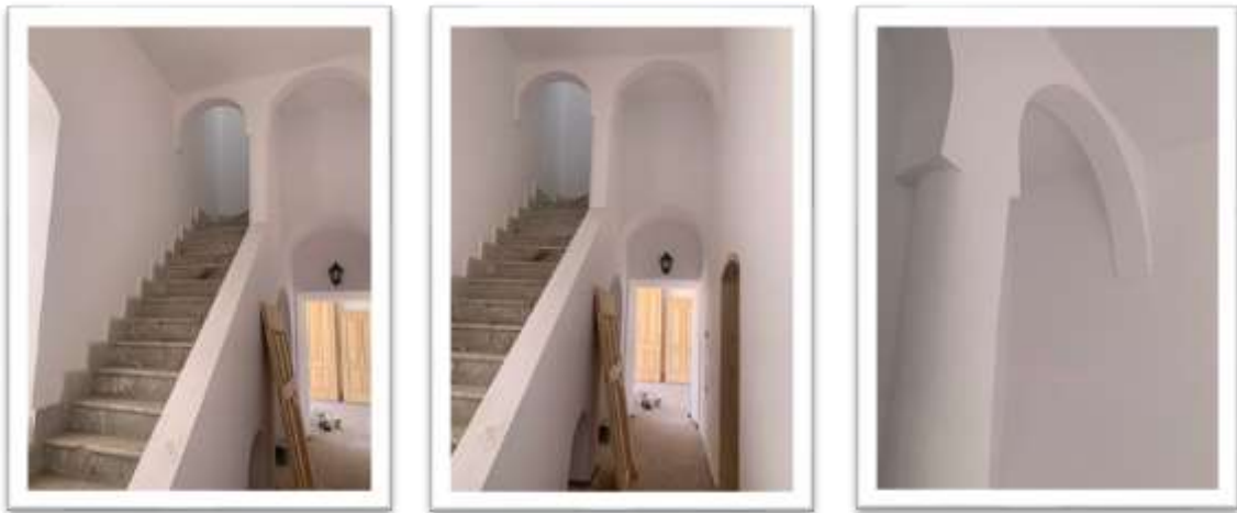
شكل (15): يوضح تفاصيل بيت الدرج. المصدر : تصوير الباحث
