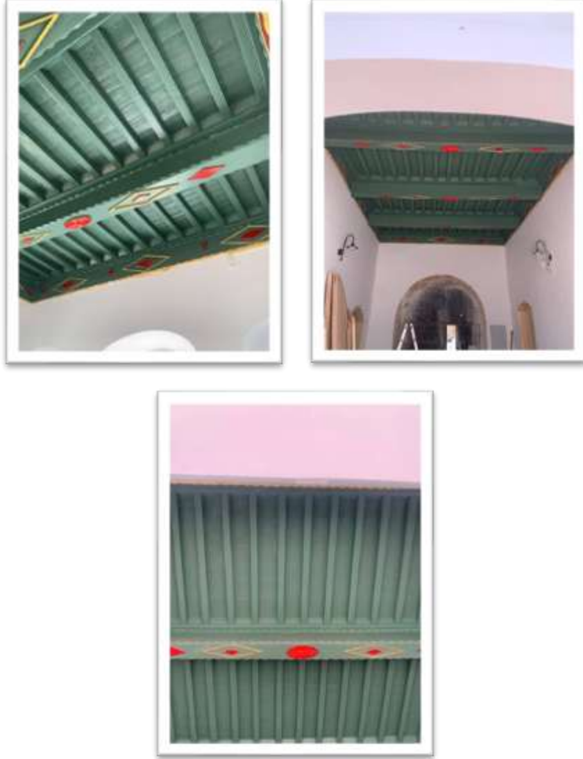
شكل (10): يوضح السقف الخشبي للمبنى والزخارف، حيث تم ترميم سقف المبنى باستخدام كمرات حديدية وخشب والخرسانة الرغوية المصدر : تصوير الباحث
