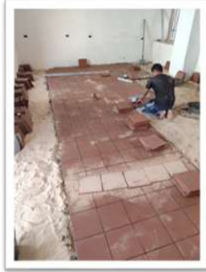
شكل (9): يوضح عملية تبليط الأرضيات
