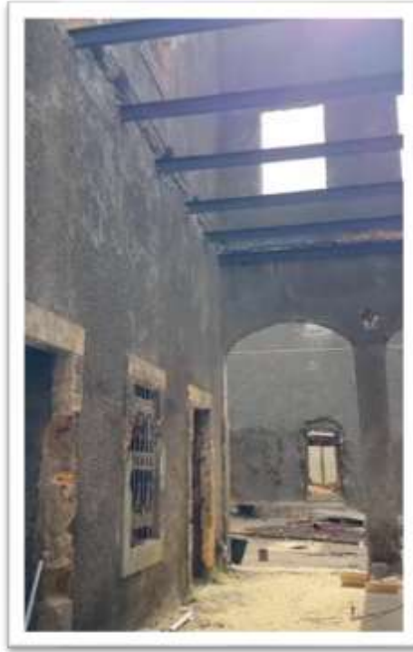
شكل (7) : صور للمبنى قبل بدء عملية الصيانة الحالية
